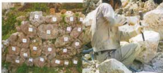
修理作業の様子
