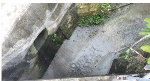
河川底の修繕後
