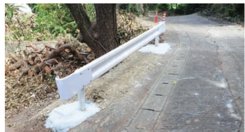
ガードレール設置状況
