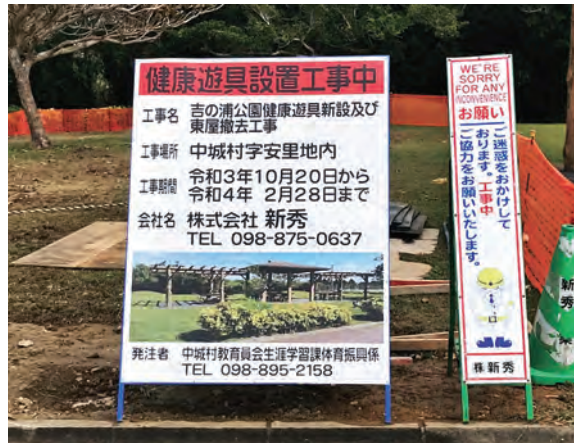
工事看板状況
