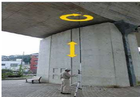
写真-1 【橋梁点検ロボットカメラ】
