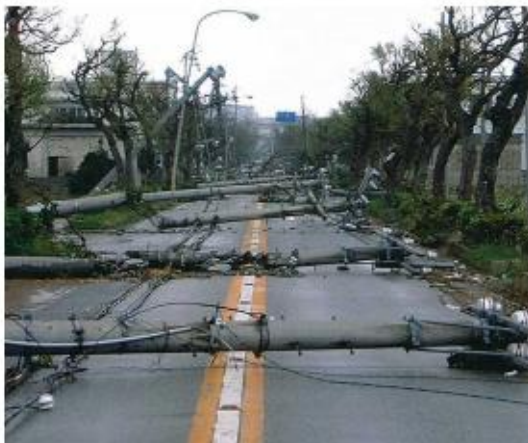
写真－1 台風による電柱倒壊状況
