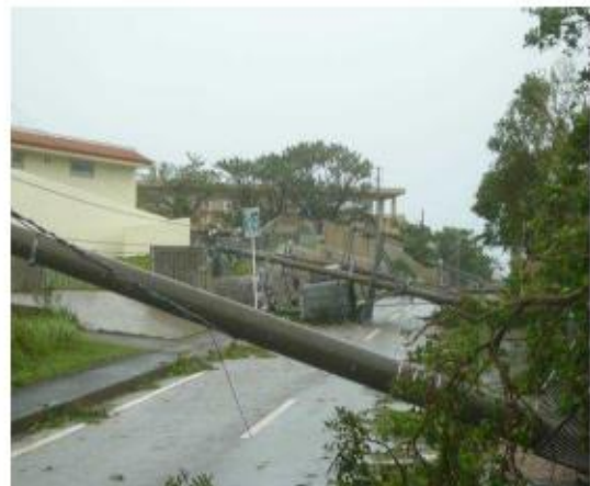
写真－1 台風による電柱倒壊状況
