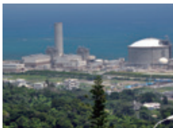
吉の浦 LNG 火力発電所
