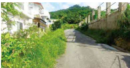
サンヒルズタウン近くの村道と側溝
