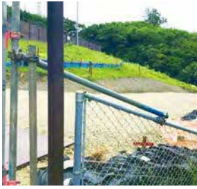
沖縄電力変電所
