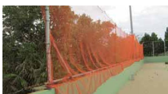
生涯学習課長 フェンス支柱の撤去作業を始め支柱が錆びている所は、今回で全て撤去し、簡易ネットを上に、レールを通してカーテン式のネットをやっています。
