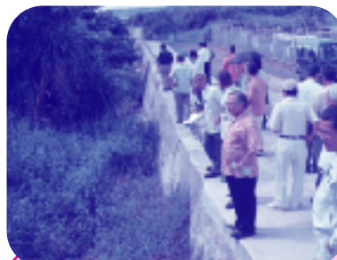
護岸に土が溜まり草地となっている
