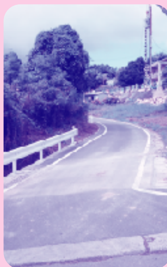
すでに完成している区間
