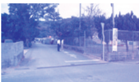
第二保育所付近の側溝
