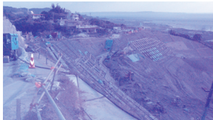
村道坂田線復旧工事現場
