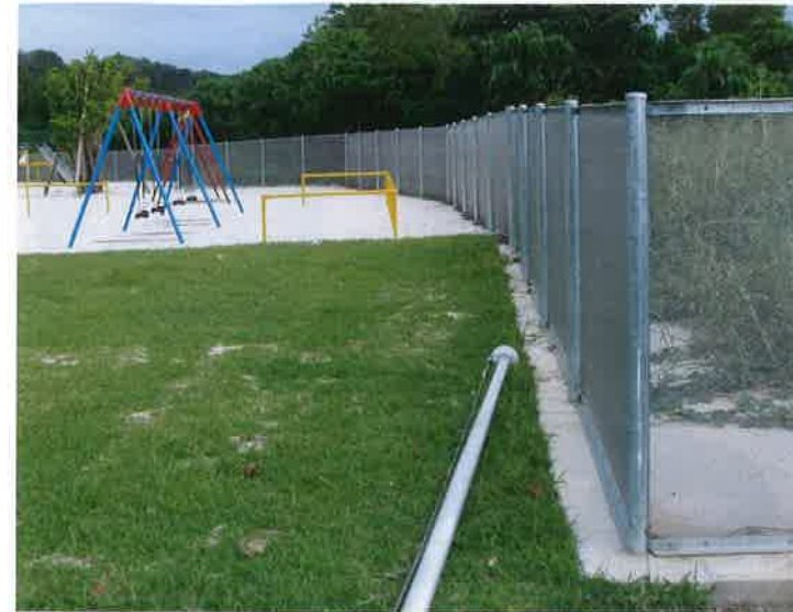
ハブの侵入を防ぐフェンス
