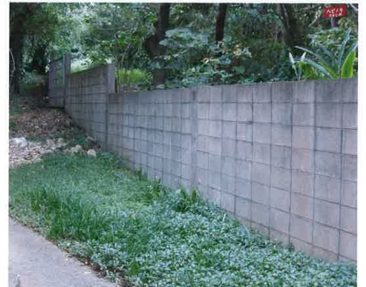
ハブの侵入を防ぐブロックべい
