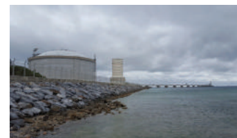
吉の浦火力発電所
