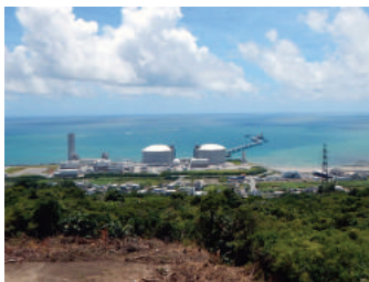
吉の浦火力発電所
