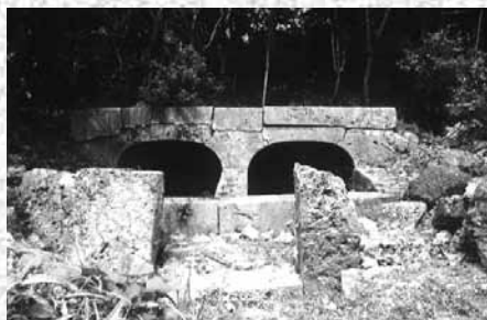
村内に現存する豚小屋（ウワフル）
