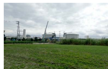
沖縄電力吉の浦火力発電所
