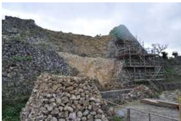
崩れた一の郭北側の城壁(野面積み)
