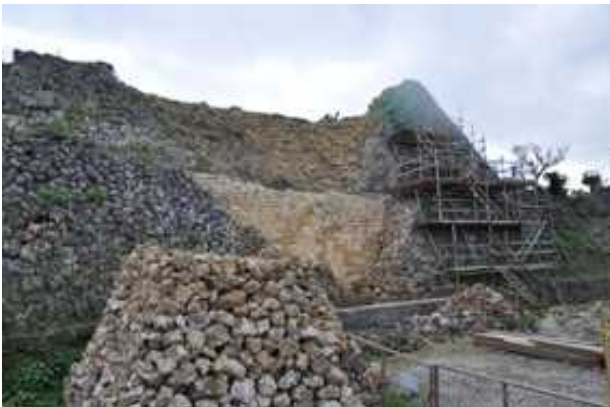
崩れた一の郭北側の城壁(野面積み)
