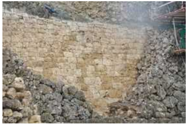
14C前半に積まれた城壁(布積みに見える)
