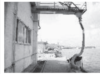
▲排出口 (パイプの先から氷がでます)
