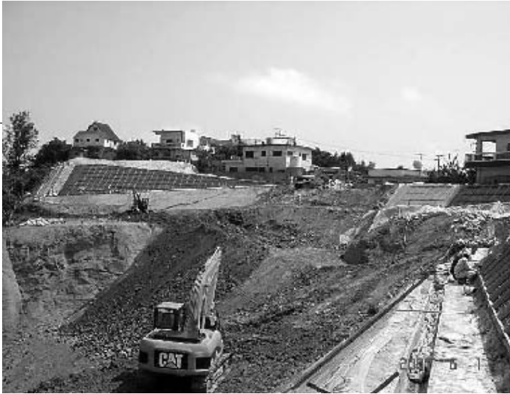
安里・北上原地区土砂災害の復旧対策
