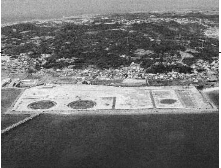
吉の浦火力発電所
