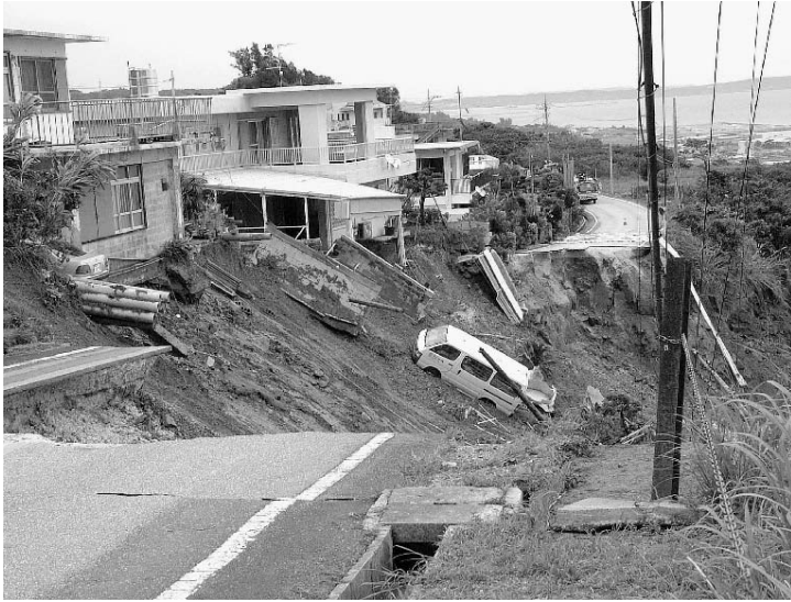
昨年6月に発生した土砂災害
