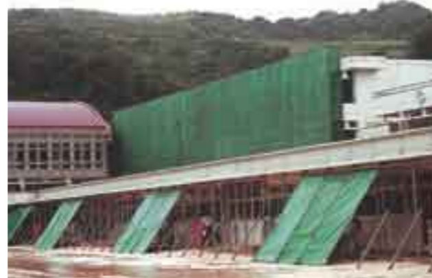
防衛施設周辺整備事業による防音工事（津覇小学校）
