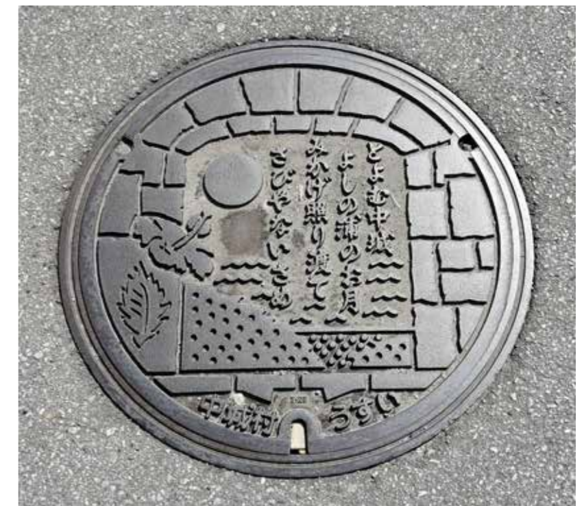
雨水マンホールの蓋
