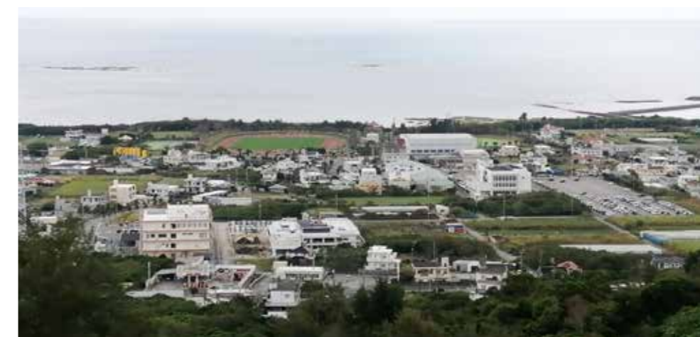
タウンセンター地区（役場庁舎周辺）
