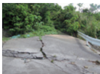
2006年の大規模地すべり後も道路の隆起があり、対策が求められている。
