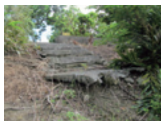
下部より亀裂が生じ、崩壊の危険がある。
