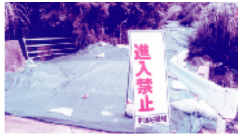
道路陥没現場の現状
