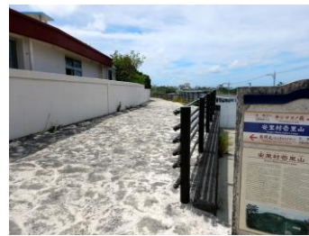
ハンタ道整備
