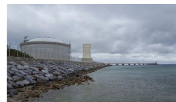
吉の浦火力発電所
