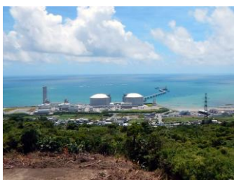
吉の浦火力発電所
