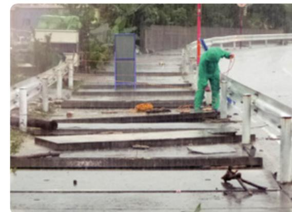
奥間から浜へ流れる浜線の排水路が、豪雨の際、氾濫し排水路の蓋が浮き上がり道路冠水が起き非常に危険な状態となった。側溝蓋の浮き上がらないよう即脱側溝蓋の改善が必要である。
