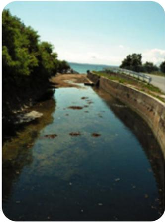
▲ 泊地先の排水路流末。砂が堆積して水の流れが止まっている。
